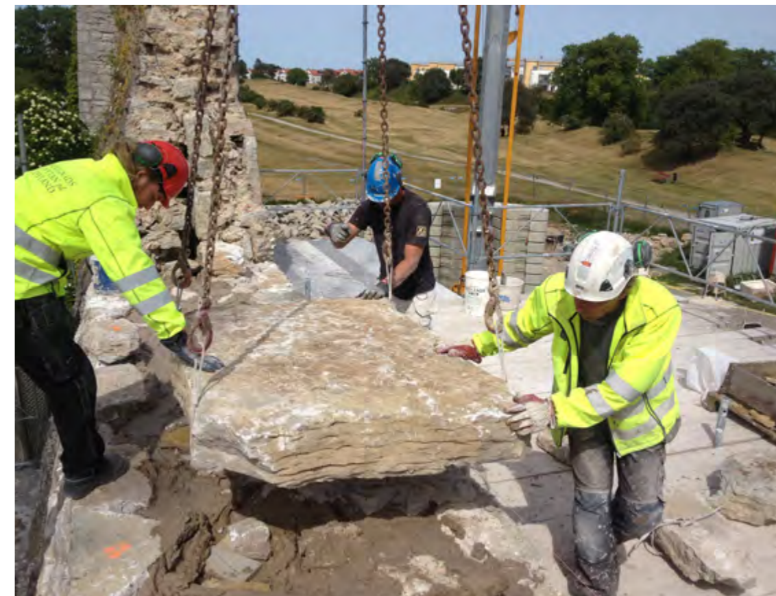
Återuppbyggnad av stadsmuren efter ringmursrasen 2012.
