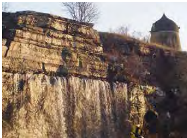
Bild 3. Bergskärning i Visby (vid Färjeleden) som visar ett starkt vattenförande horisontellt spricksystem. Här finns också vertikala vattenförande sprickor.
