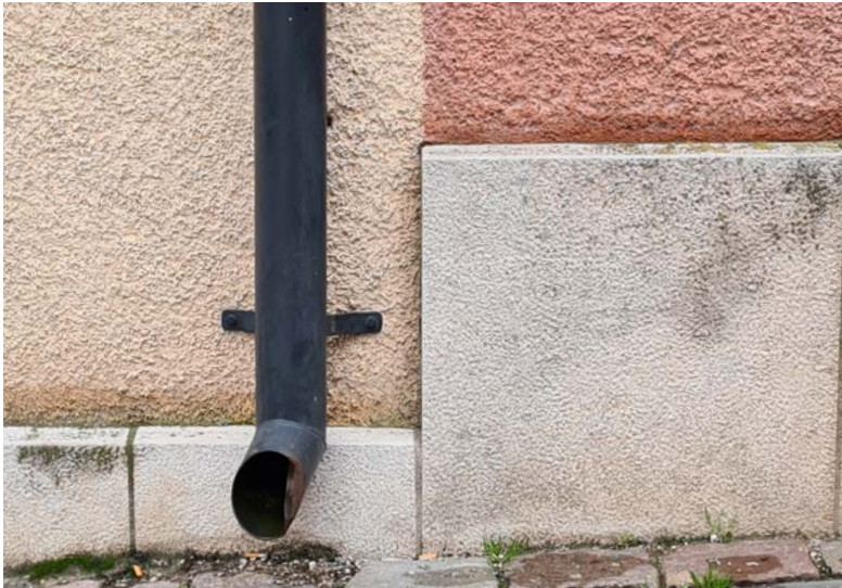
Krysshuggen kalkstenssockel på murverk uppfört 1988. Bearbetning och utformning passar väl in i miljön men visar samtidigt att det rör sig om en yngre byggnad som försökts att anpassa till omgivningen.
